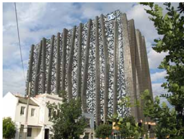
La Facultat d'Econòmiques de la Universitat de Melbourne (Austràlia) coneguda com "the spot" és el primer edifici guardonat amb 5 estrelles verdes pel Consell d'Edificacions Verdes d'Austràlia. Més informació a: http://www.gbca.org.au/green-star/green-building-case-studies/
